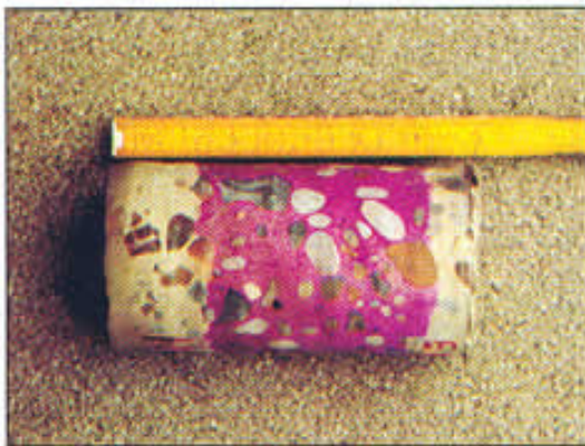
FOTO 1: Testigo de hormigón donde se detecta la zona carbonatada por ausencia de color fucsia.
